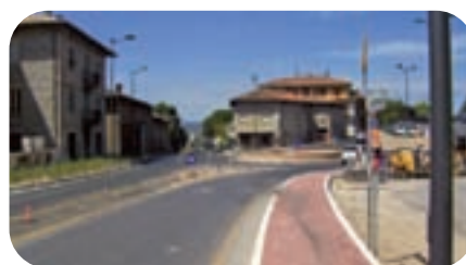
La rotonda in via Gramsci ha migliorato notevolmente il flusso del traffico.
